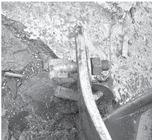
Obr. 14 Chyby při osazení kotev – nedostatečná hloubka ukotvení přední chemické kotvy (z pohledu fotky), nedostatečná hloubka zapuštění zadní mechanické kotvy
