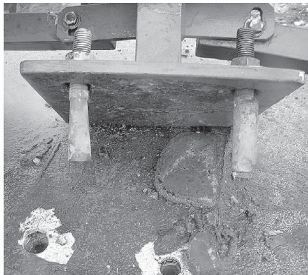
Obr. 14 Chyby při osazení kotev – nedostatečná hloubka ukotvení přední chemické kotvy (z pohledu fotky), nedostatečná hloubka zapuštění zadní mechanické kotvy
