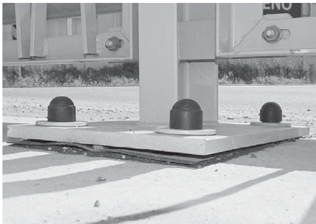
Obr. 12 Stav neošetřeného prostoru pod patní deskou sloupku po několika měsících provozu
