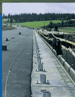
Kotvení svodidel, říms a mostního příslušenství dálnice Hybe – Važec.
