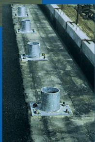
Kotvení svodidel, říms a mostního příslušenství dálnice Hybe – Važec.
