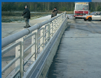
Nový typ zábradelního svodidla ZSNH4/H2 – výrobce ISPAT NOVÁ HUŤ a. s.
