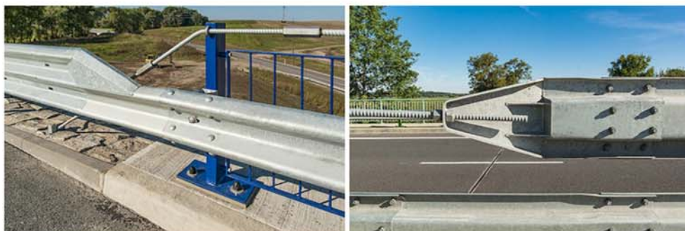
Obr. 3 Příklady přechodových prvků na realizovaných stavbách (Opava, Třeboň)
