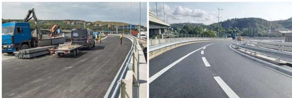
Obr. 4 Barrandovský most, 2. etapa, svodidla ZMS4-A3/H2 a ZMS4/H3
