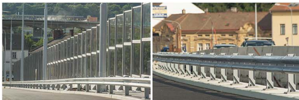
Obr. 5 VMO Brno – Tomkovo nám., 2.etapa, svodidlo MS4-A3/H2
