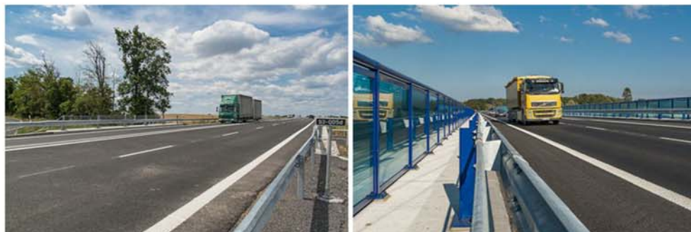
Obr. 8 I/53 Práche (ZMS4-A3/H2) a I/11 Opava, různé objekty a typy svodidel
