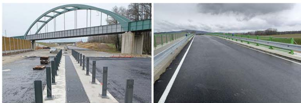
Obr. 6 D3 úsek Hodějovice-Třebonín, různé objekty a typy svodidel
