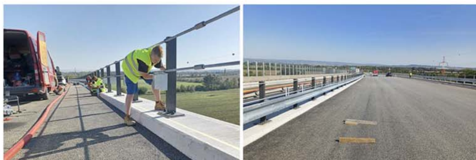
Obr. 9 D35 Instalace svodidel ZMS4/H3 při rekonstrukci mostů
