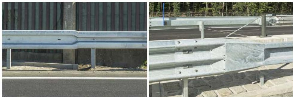
Obr. 5 Přechodové prvky na svodnice jiných výrobců
