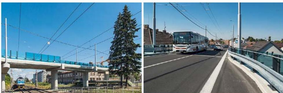
Obr. 7 Pardubice, most M117 Kyjevská, ZMS4-1/H2 s polykarbonátovou zábradelní výplní
