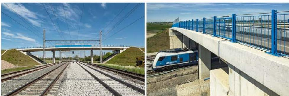
Obr. 6 Most PŘ-M01 přes žel. koridor (Přerov), ZMS4/H3 svislá zábradelní výplň
