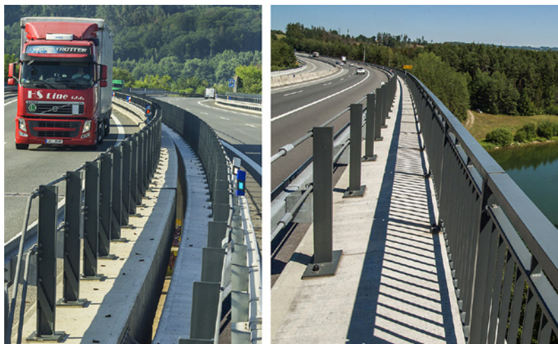
Obr. 6 Zábradelní mostní svodidlo ZMS4/H3 – most na D-10 u Březiny (2017) a Vojslavický most na D-1 přes údolí Želivky, v.n. Švihov (2018)
