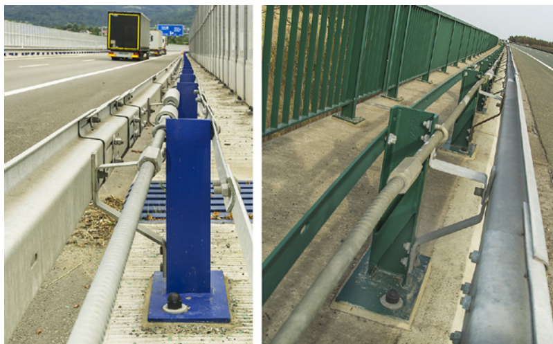
Obr. 2 Mostní svodidlo MS41/H2 – most přes Olši na D-11 (býv.I/68) (2016) a most na D-35 u Sedlic (2009)
