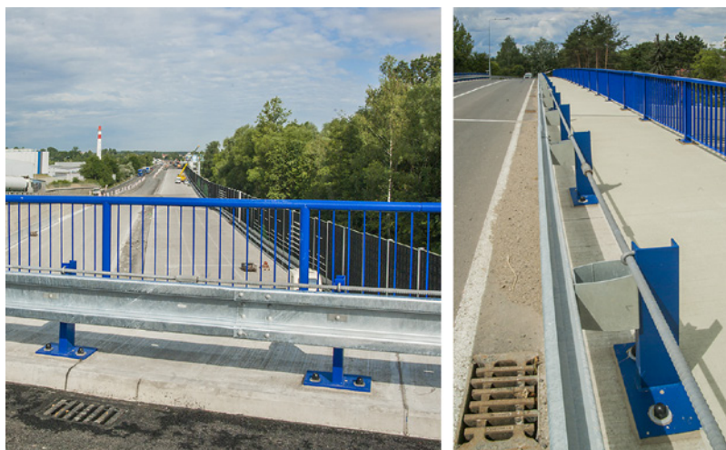
Obr. 4 Mostní svodidlo MS4-1/H2 – nově budovaná D-48 u Příbora (2019) a most přes D-46 u Olšan (2018)
