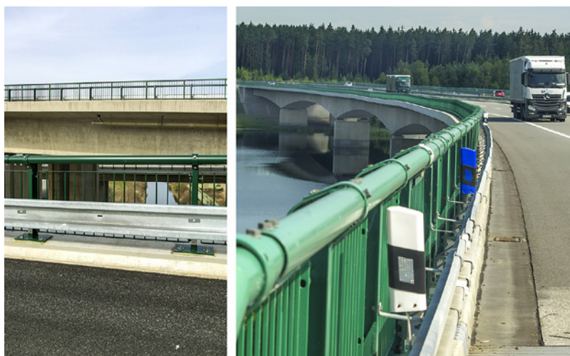
Obr. 3 Zábradelní mostní svodidlo ZMS4/H2 – třípatrová křižovatka u Opatovic (2016) a most přes rybník Koberný na D3 (2012)
