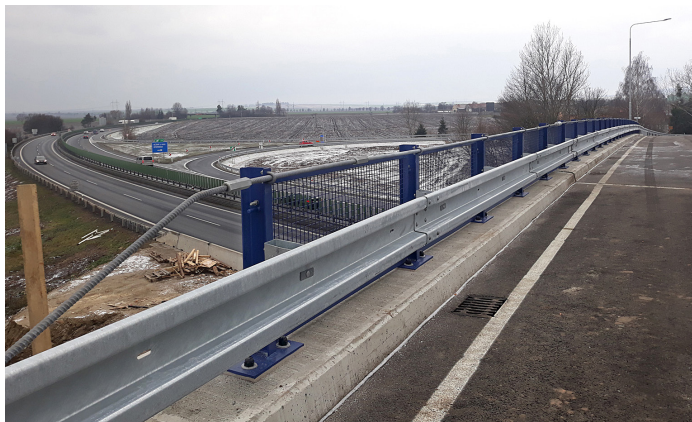
Obr. 8 Jedna z prvních realizací svodidla ZMS4-1/H2 se sítovou výplní na podzim roku 2018 na silnici III-5707 přes D46 u Olšan u Prostějova
