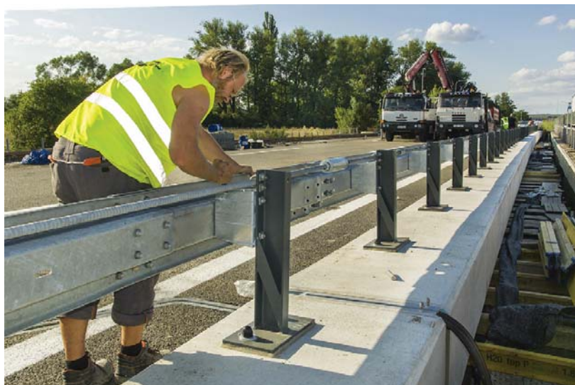
Obr. 8 Instalace nového svodidla MS4-1/H2 na mostě D2-002
