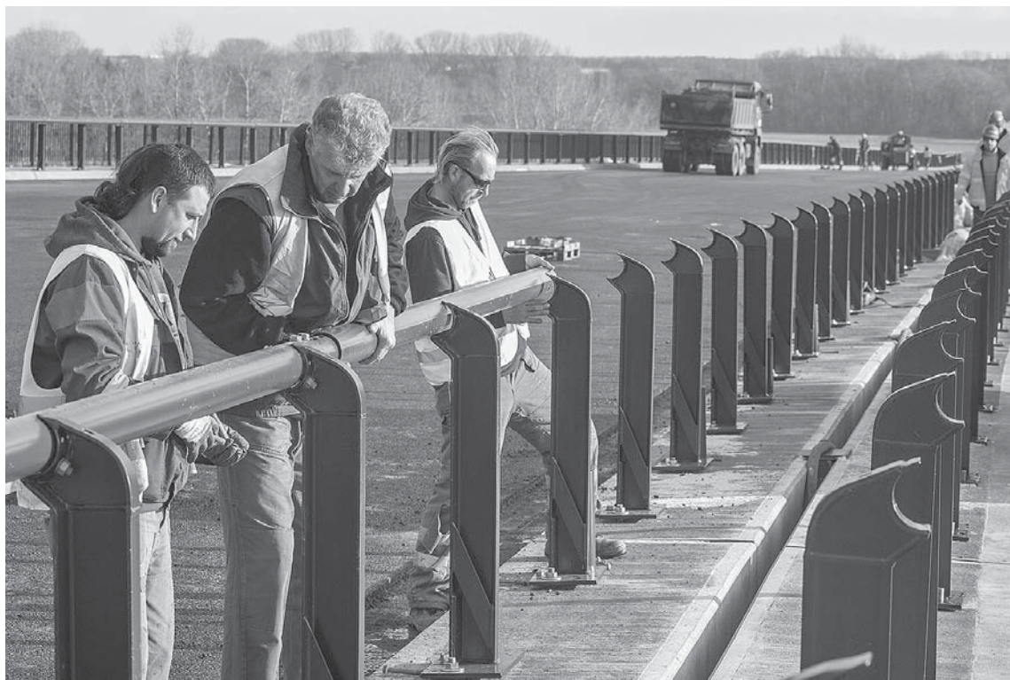
Obr. 5 Montáž zábradelních svodidel ZMS4/H2 na estakádě ve směru na Časy (Olomouc)
