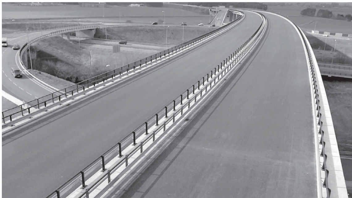
Obr. 8 Pohled na estakádu ve směru na dálnici D11 se svodidly ZMS4/H2
