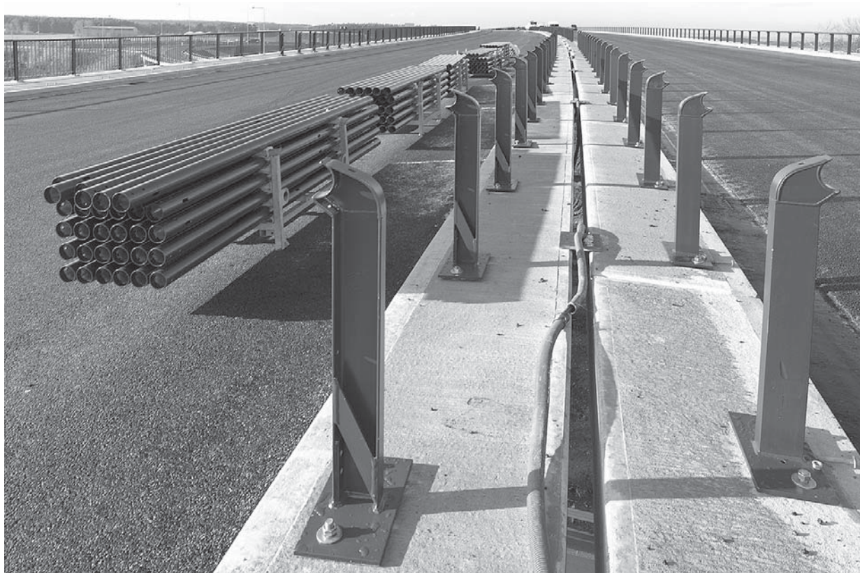
Obr. 4 Pohled ve směru dálnice D11, postup montáže
