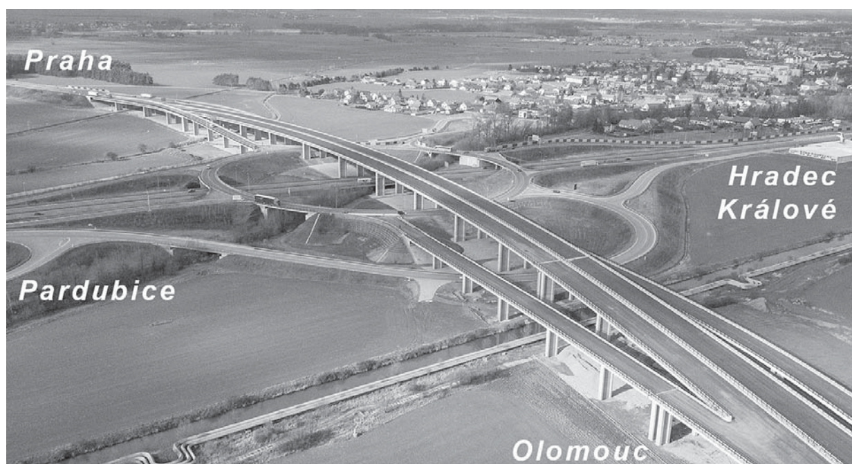
Obr. 1 Letecký pohled na třípatrovou MÚK, v pozadí vpravo Opatovice nad Labem
