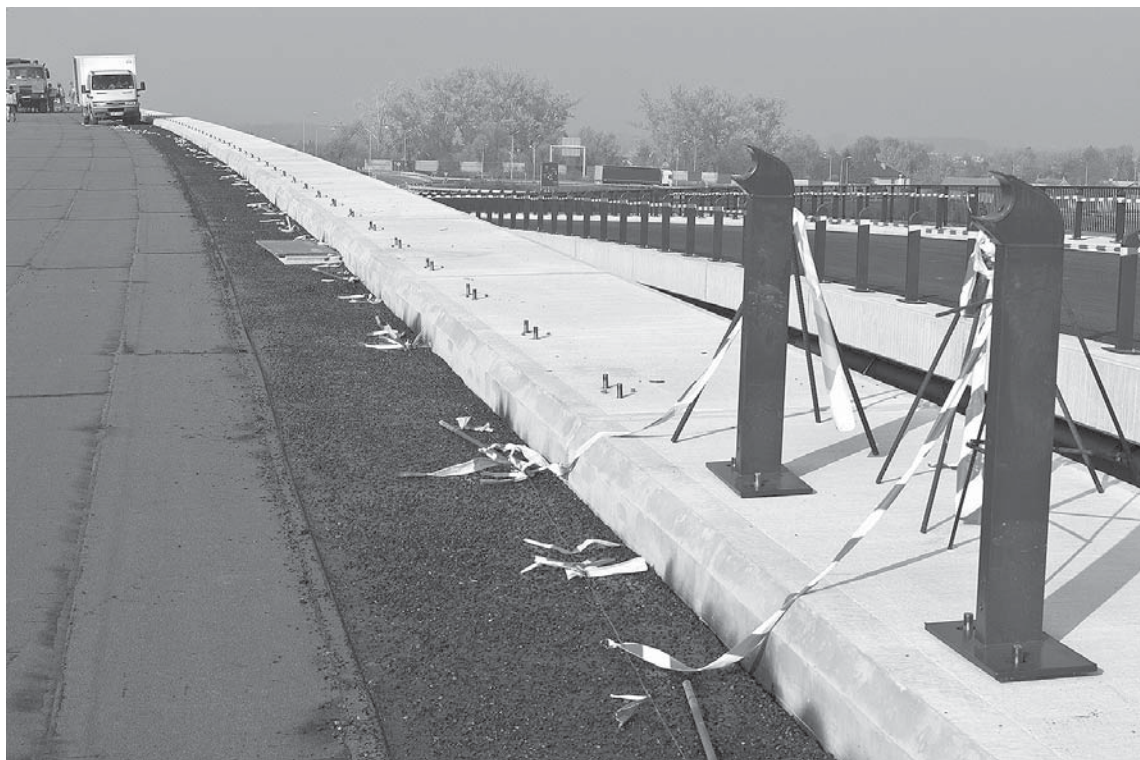
Obr. 7 Připravené kotevní prvky k montáži svodidel
